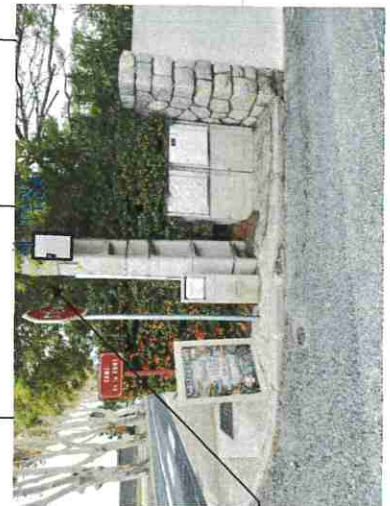
Pose du C400P200 sur le poteau avec ferrure spéciale et à hauteur d'homme
