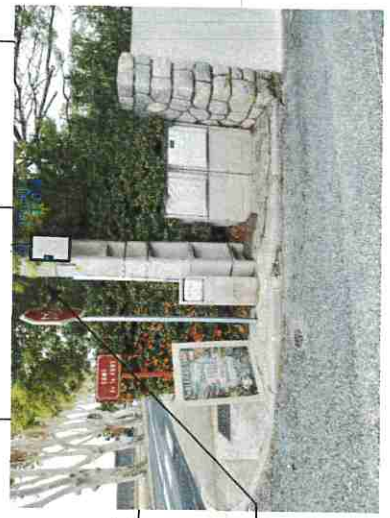
Pose du C400P200 sur le poteau avec ferrure spéciale et à hauteur d'homme
