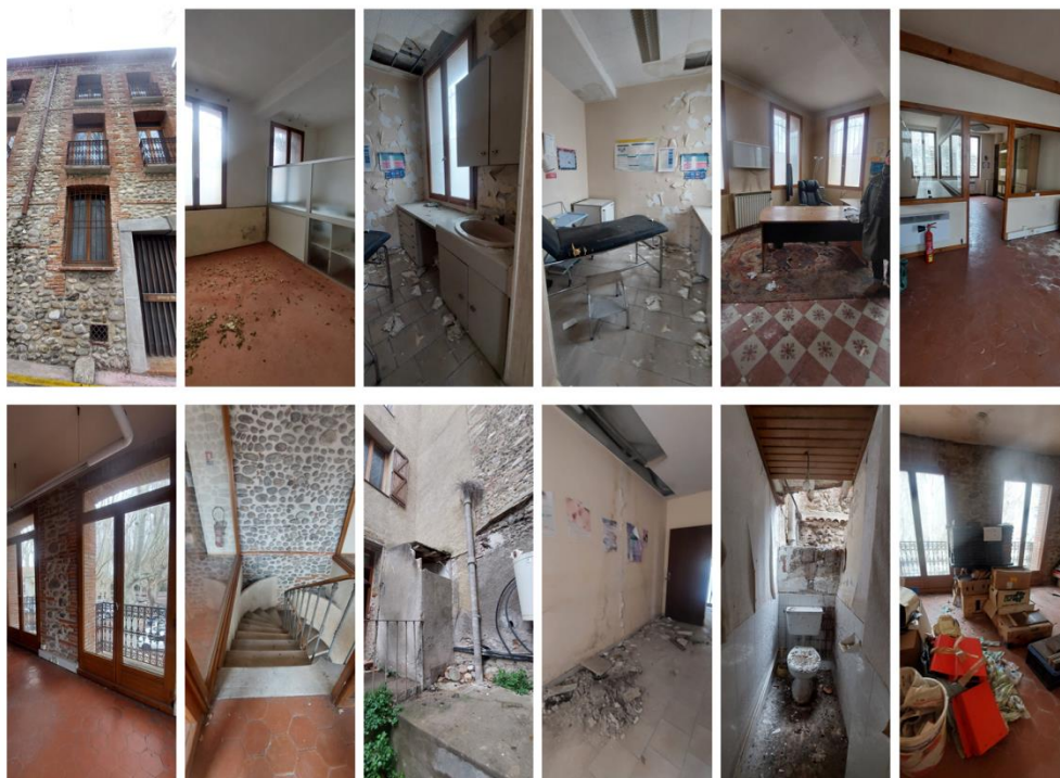
Photos du bâtiment Hoogland en état (avant rénovation)
